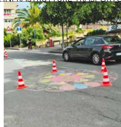
2A e 2B. Mini-rotatoria: fase di realizzazione e risultato finale
